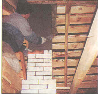
20. В пределах чердака трубу оштукатурили и побелили.
