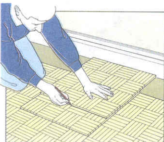
Раскроить панель по стыкам плашек можно, прорезав подложку ножом.
