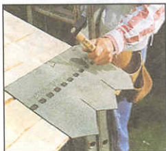
Полосы «гонта» укладывают снизу вверх — первый ряд со свесом, второй — вразбежку с перекрытием половиной верхней части первого ряда.
