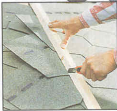
На ребрах между гранями крыши выступающие части «гонта» обрезают острым ножом.
