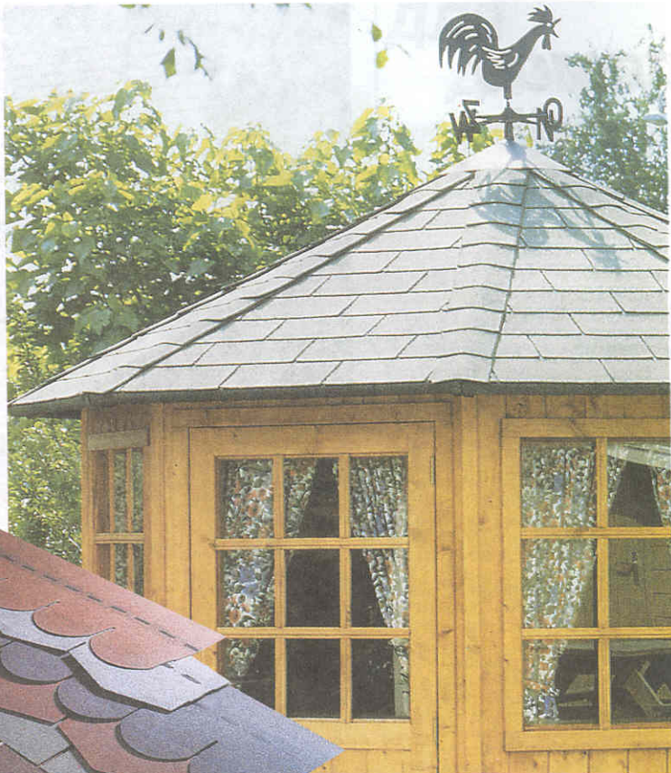
Полосы «гонта» из элементов в виде «бобрового хвоста», треугольников и четырехугольников. Верхние участки полос, укрытые защитной пленкой, имеют клейкий слой.
