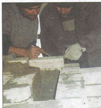
12, 13. Кирпичи на внутренних стенках газоходов подрезали и затерли поверхности стенок, чтобы ничто не препятствовало созданию хорошей тяги.
