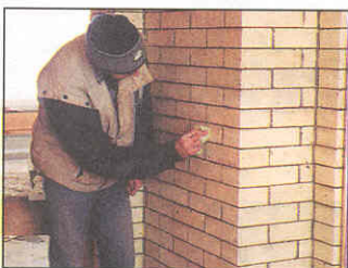
23. Испачканные глиняным раствором кирпичи можно легко очистить смоченным в воде поролоном.
