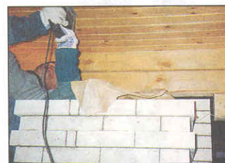
15, 16. При разметке и вырезании проема под трубу важно учесть расположение балок перекрытия.
