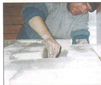
12, 13. Кирпичи на внутренних стенках газоходов подрезали и затерли поверхности стенок, чтобы ничто не препятствовало созданию хорошей тяги.
