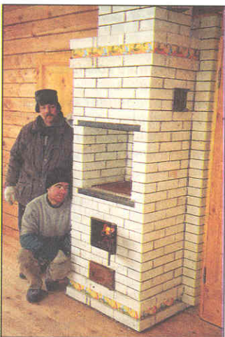
Пробная топка. Отсутствие дымления при открытой топке свидетельствует о хорошей тяге.
