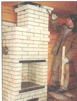
17. Ультралегкий шамотный кирпич позволяет сократить противоположное расстояние «до дыма».
