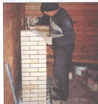
18, 19. Трубу выкладывали на глиняно-песчаном растворе, постоянно контролируя ее вертикальность по уровню.
