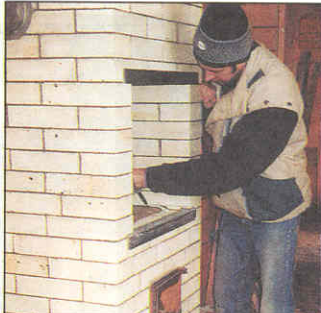
22. Зазоры между кладкой и варочной плитой заполнили асбестовым шнуром.
