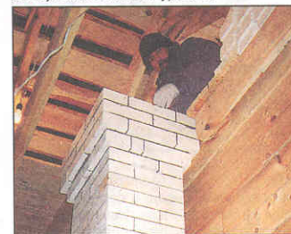
18, 19. Трубу выкладывали на глиняно-песчаном растворе, постоянно контролируя ее вертикальность по уровню.
