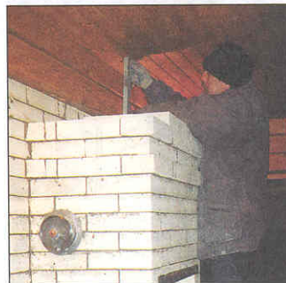
15, 16. При разметке и вырезании проема под трубу важно учесть расположение балок перекрытия.
